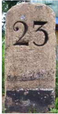
ඡා.එ. 6,7 කොළඹ - නුවර මහාමාර්ගයේ පැරණි සැතපුම් කණුවක සැතපුම් අංකය සහ පිළිමතලාව නානුමය පැරණි පාලමේ සමරු ඵලකය (V Cut ක්‍රමය අනුව අක්ෂර කොටා තිබේ)
